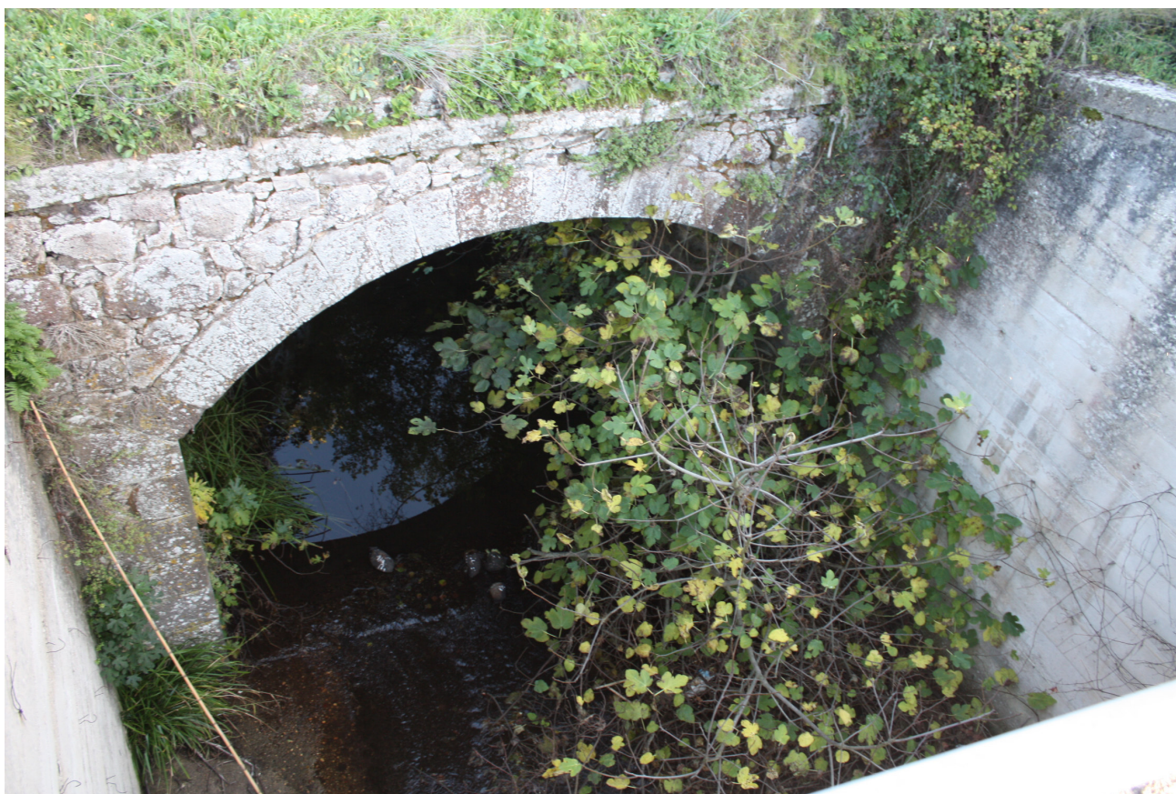
Documentazione fotografica, sezione di verifica vecchio Ponte Luzzanas
