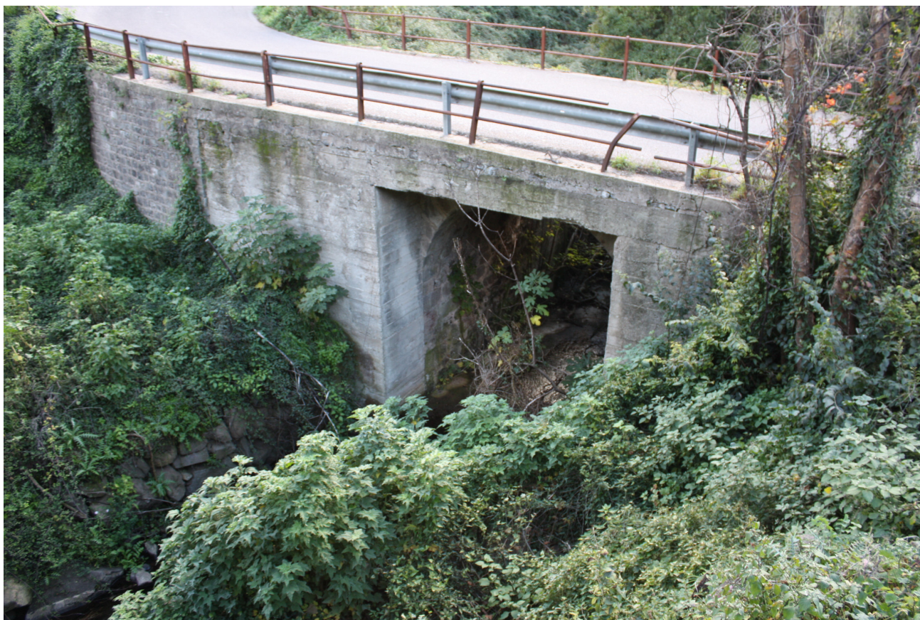
Documentazione fotografica, sezione di verifica Ponte Cambone
